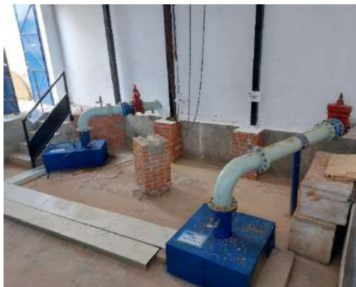
Figura 6. Vista interior pozos de captación
