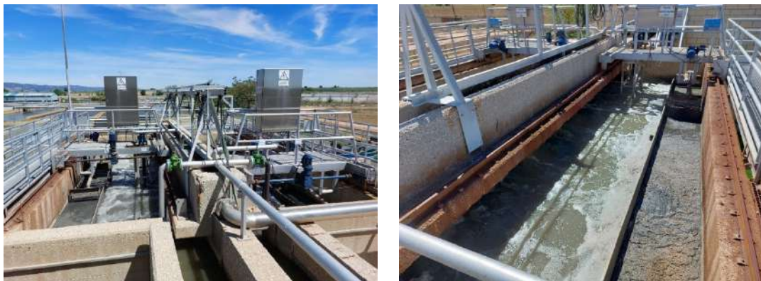
Figura 46. Desarenador-desengrasador.
