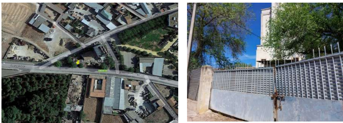
Figura 24. Localización y vista exterior del bombeo zona alta de Daimiel
