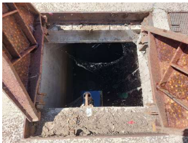
Figura 32. Cántara de bombeo de la EBAR
