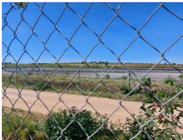
Figura 60. Tanque de tormentas de la EDAR
