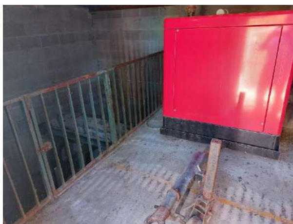
Figura 37. Grupo electrógeno
