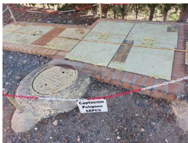
Figura 11. Captación pozo Polígono SEPES
