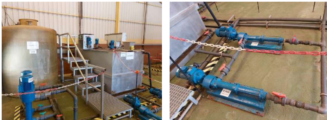
Figura 57. Depósito y equipo preparador de polielectrolito (izquierda) y bombas de dosificación del reactivo (derecha).
