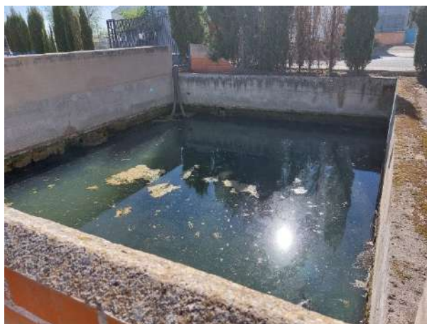
Figura 15. Balsa de salmuera de la limpieza de los tanques de descalcificación
