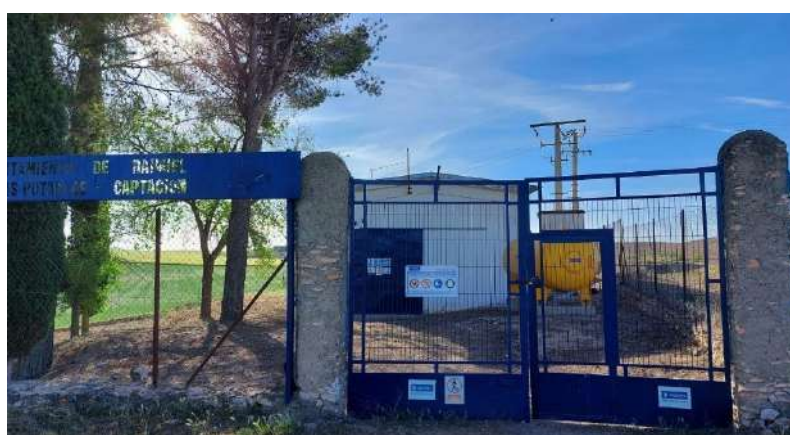
Figura 5. Foto exterior instalación de los pozos de captación
