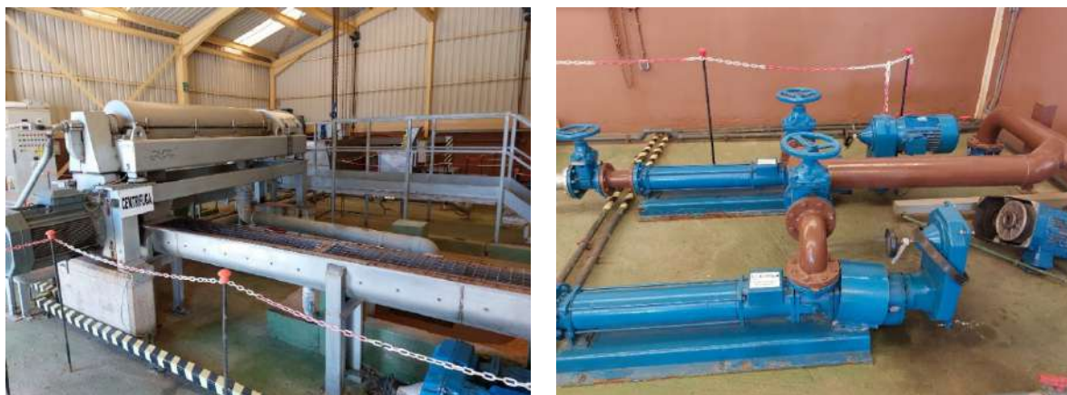
Figura 57. Depósito y equipo preparador de polielectrolito (izquierda) y bombas de dosificación del reactivo (derecha).
