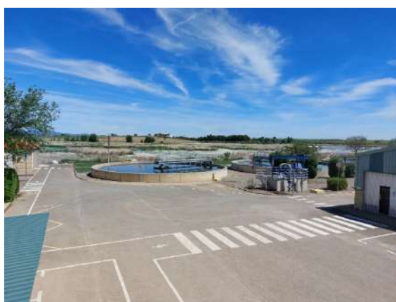
Figura 51. Decantadores secundarios
