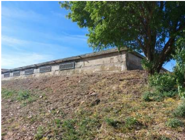
Figura 17. Vista exterior Depósito nº1.
