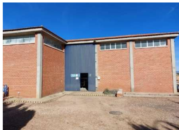
Figura 10. Vista exterior de la ETAP
