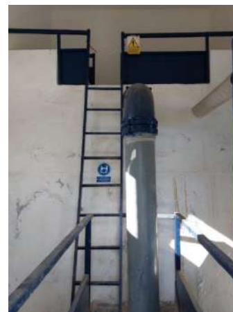
Figura 20. Vista interior Depósito nº2
