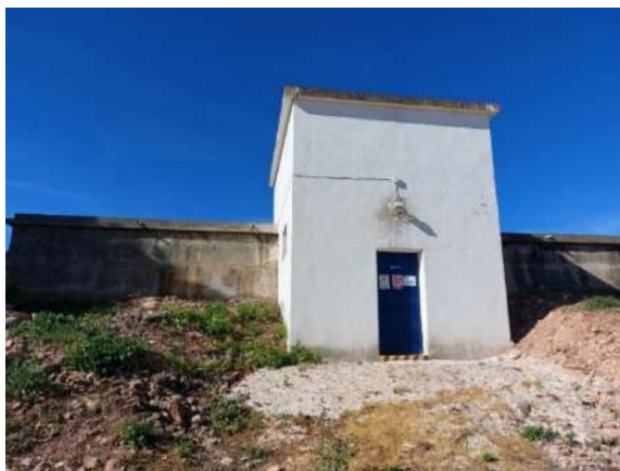
Figura 19. Vista exterior Depósito nº2.
