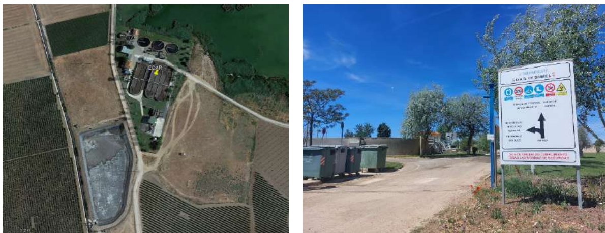
Figura 39. Localización y entrada a la EDAR de Daimiel
